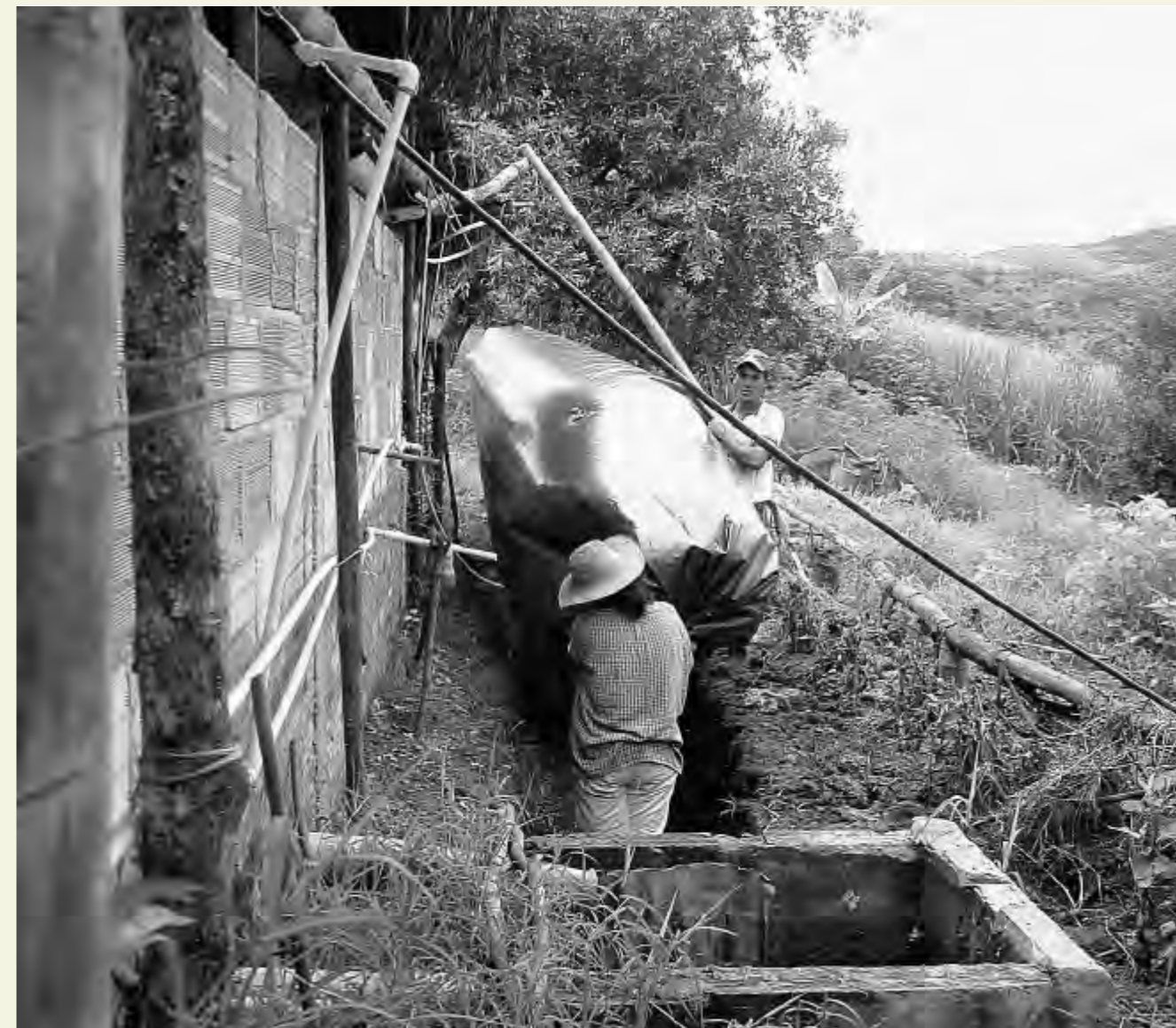
Le biodigesteur placé dans la tranchée. Photo : Lylían Rodríguez
