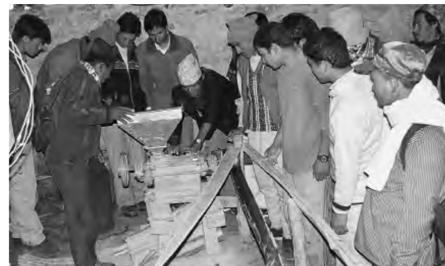
Installation d'une décortiqueuse du riz. Photo : CRT/N.
