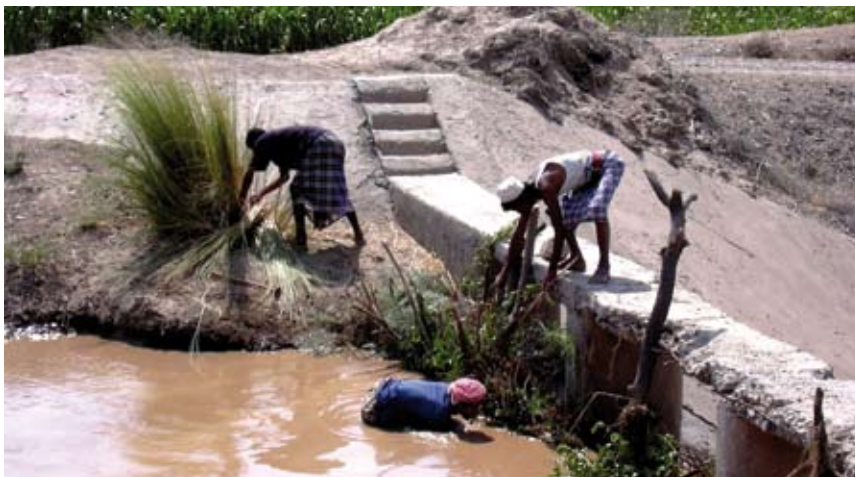
Des infrastructures simples pour aider les populations dans la gestion des crues soudaines et l'épandage des eaux de crue sur les terres : c'est le mécanisme de fonctionnement de « l'irrigation de crue »
