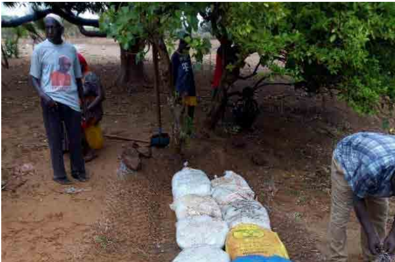
Réalisation d'un pont filtrant dans la commune de Keur Moussa
