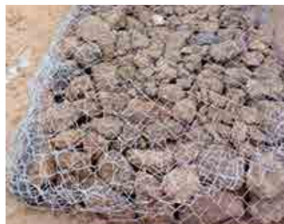
Pont filtrant au stade final
