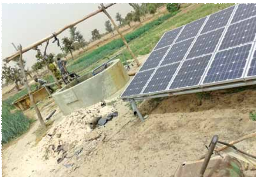
Système d'exhaure en énergie solaire photovoltaïque au niveau de la ferme pilote agro-écologique de Ndiob
