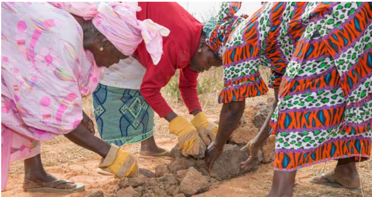
Pose de digue anti-Erosive par les femmes
